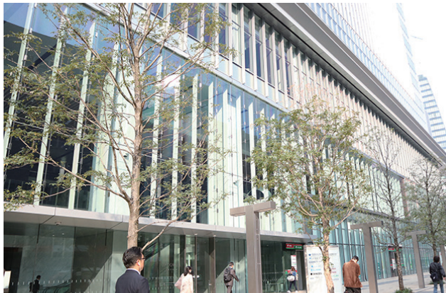
JP タワー KITTE 外構植栽・屋上緑化 壁面緑化・灌水工事
