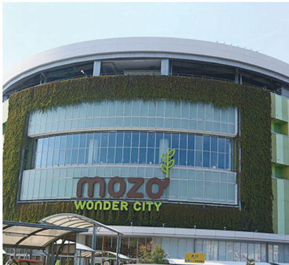
mozo ワンダーシティ 壁面緑化・灌水工事
