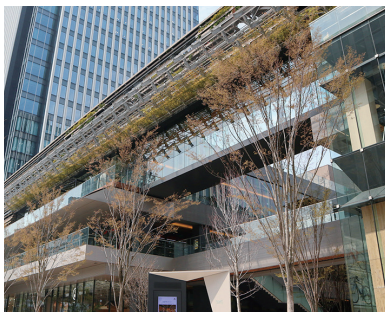
ささしまグローバルゲート 外構植栽・屋上緑化 壁面緑化・灌水工事
