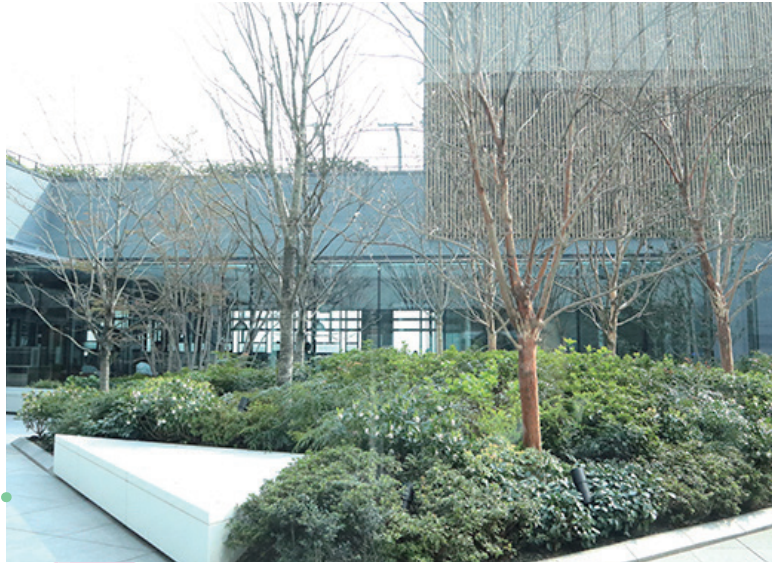
JR ゲートタワー 外構植栽・屋上緑化・灌水工事
