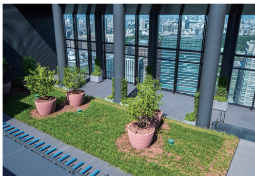
東京ミッドタウン八重洲 外構植栽・屋上緑化・壁面緑化・灌水工事
