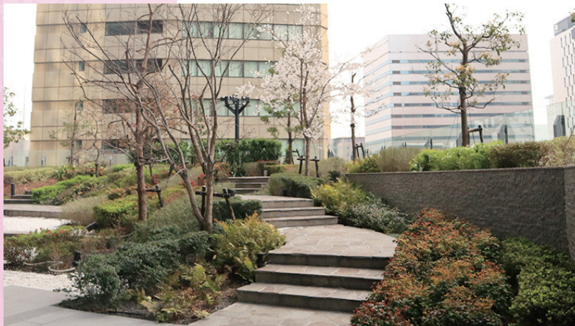
大名古屋ビルヂング 外構植栽・屋上緑化・壁面緑化・灌水工事
