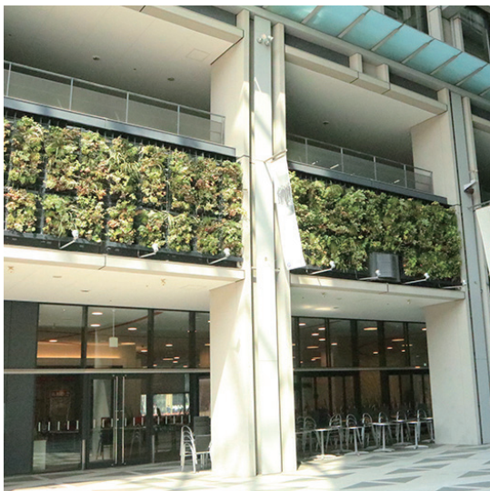
愛知大学名古屋キャンパス 外構植栽・屋上緑化・壁面緑化・灌水工事
