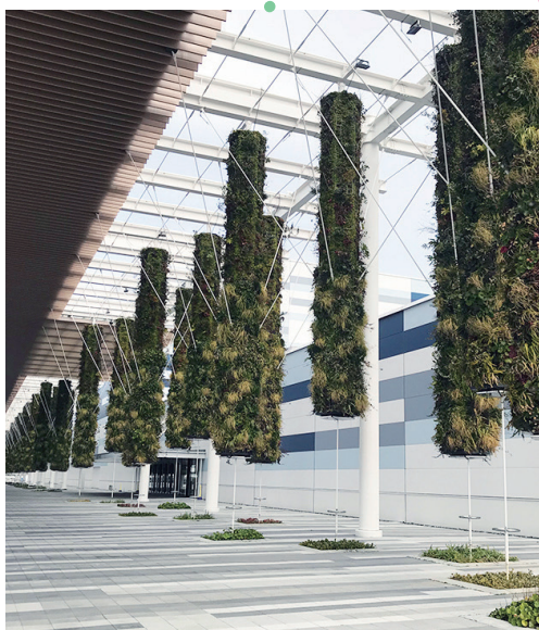
愛知国際展示場 外構植栽・壁面緑化・灌水工事
