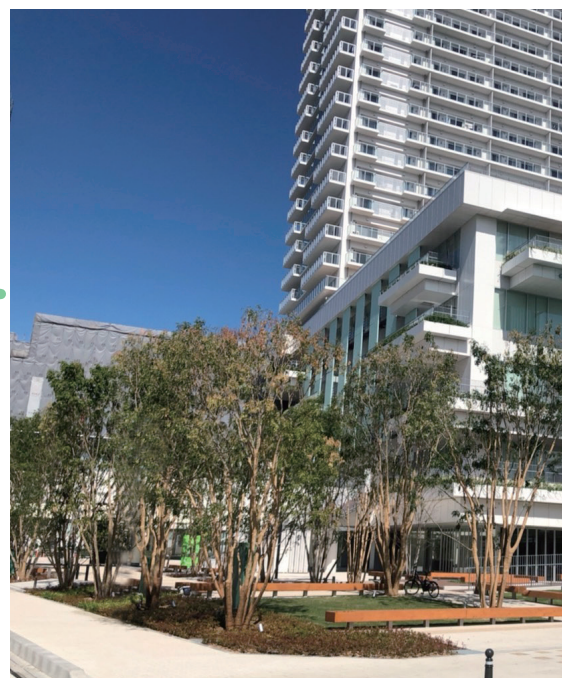
emCAMPUS・まちなか広場 外構植栽・屋上緑化・壁面緑化・灌水工事
